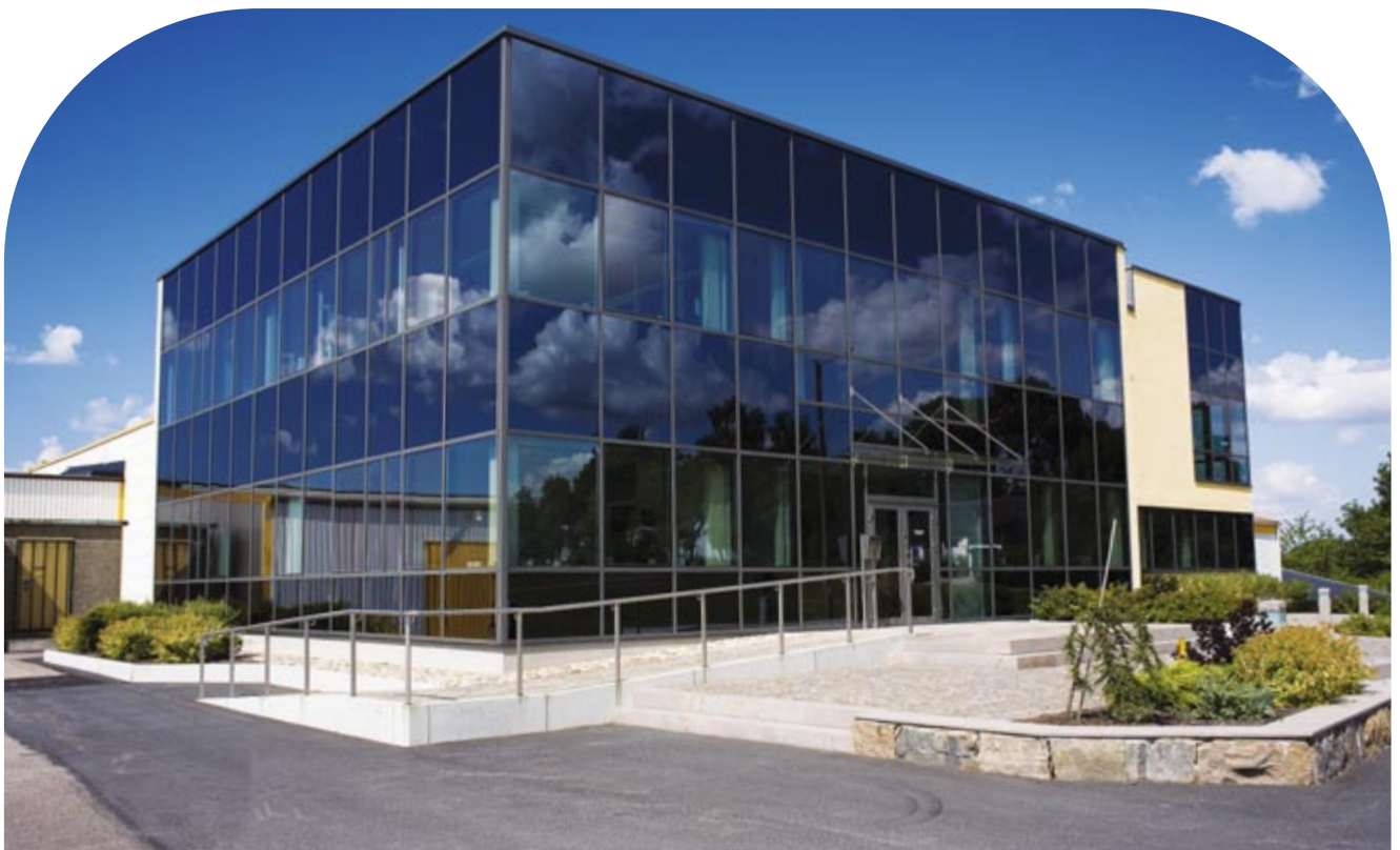
Isolierglaseinheit mit Sonnenschutzbeschichtung
